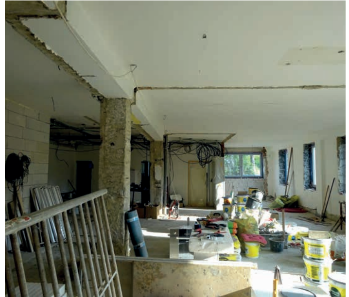
Probíhající rekonstrukce knihovny
