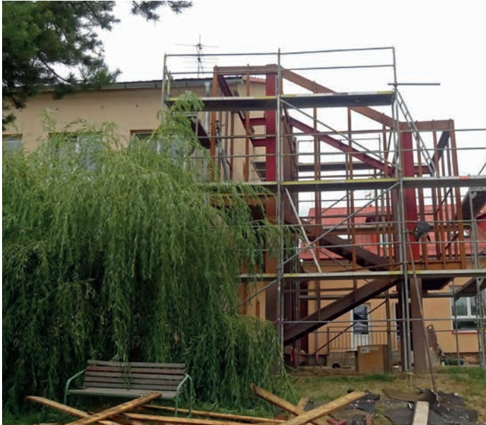
Demontáž schodiště dolní MŠ
