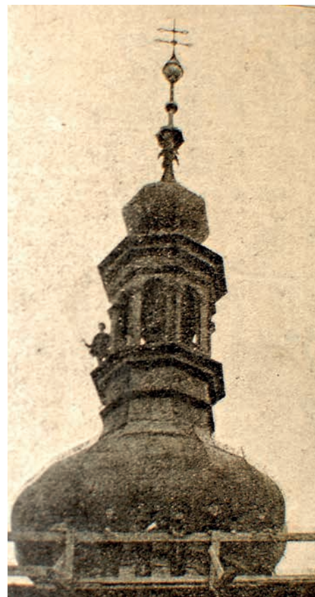
Opravená kostelní věž
