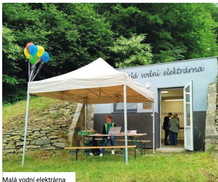
Malá vodní elektrárna
