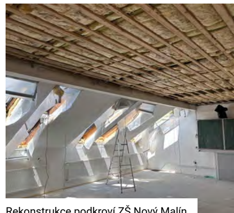
Rekonstrukce podkroví ZŠ Nový Malín
