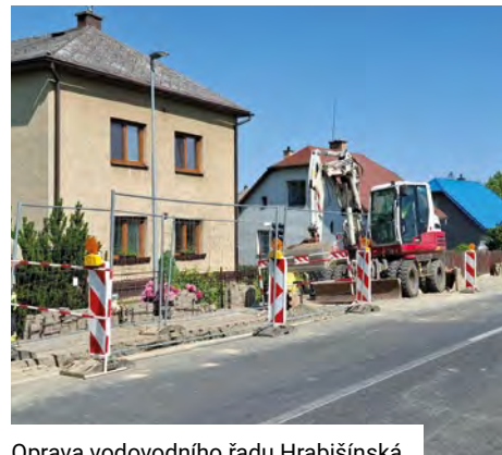
Oprava vodovodního řadu Hrabišínská
